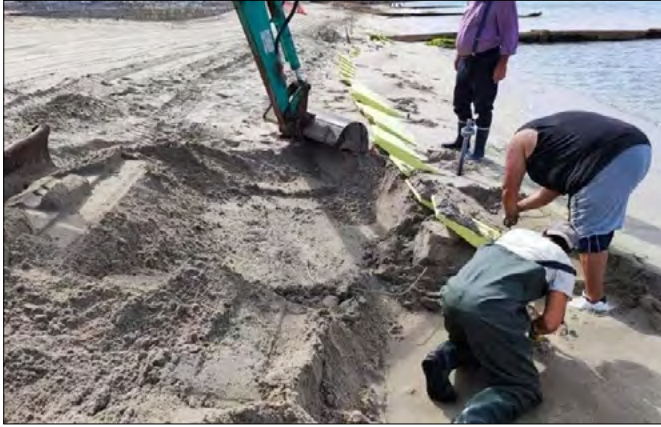
FIGURA 7. Operazioni di recupero e stoccaggio della sabbia confluita all'interno del sistema e riveniente, per trasporto naturale, dalla spiaggia sommersa.
