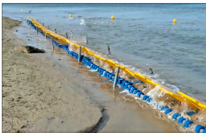
FIGURA 5. La trappola sedimentaria costituita dai moduli del sistema opportunamente posizionati lungo al linea di costa.
